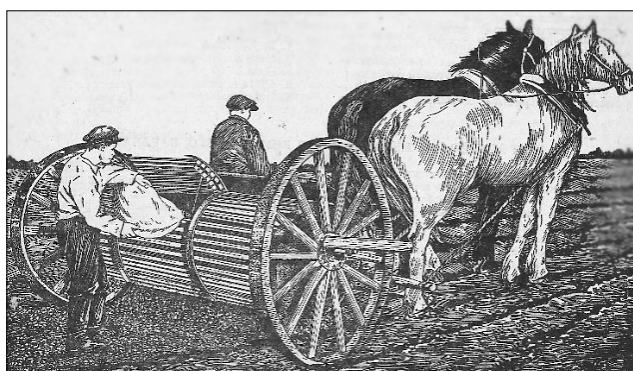
Рис. 1. Тукокоразбрасыватель TR-1 системы Б.В. Дмитриева (середина 1930-х годов), спроектированный специально для изготовления в хозяйствах
