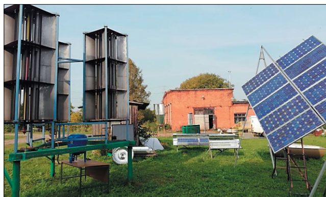
Рис. 2. Энергетический блок на ветрополигоне Fig. 2. Energy unit at the wind testing site
