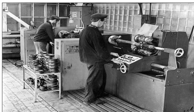
Рис. 2. Участок восстановления деталей электроконтактной наплавкой на Бронницком ремонтно-техническом предприятии (Московская область)
