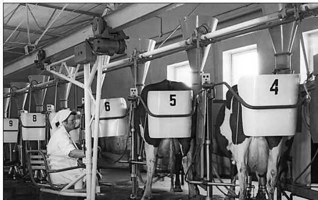
Рис. 3. Первая автоматизированная отечественная доильная установка УДА-10 «Комсомолка» с доильными станками типа «елочка» (1964 г.)
