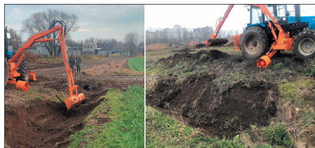
Рис. 1. Каналоочиститель ОКН-0,5 в процессе работы Fig. 1. OKN-0.5 canal cleaner in operation
