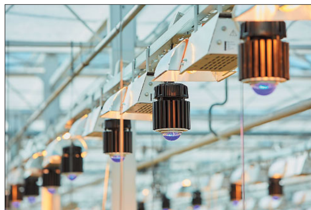
Рис. 3. Расположение корректора в ряду натриевых ламп в комбинированной облучательной установке в теплице
