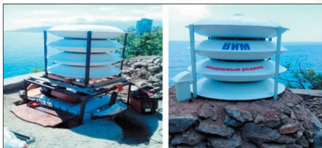
Рис. 3. Монтаж установки и внешний вид экспериментального экстрактора воды из атмосферного воздуха
