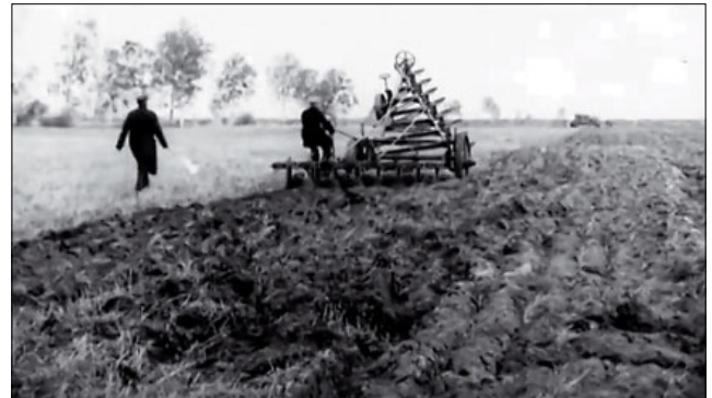
Рис. 2. Электротрактор системы А.И. Дидебулидзе на базе колесного трактора «Фордзон»
