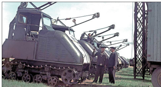
Рис. 8. Гусеничные электротрактора ЭТ-5-ЭНИН-ВИЭСХ, 1949 г.
