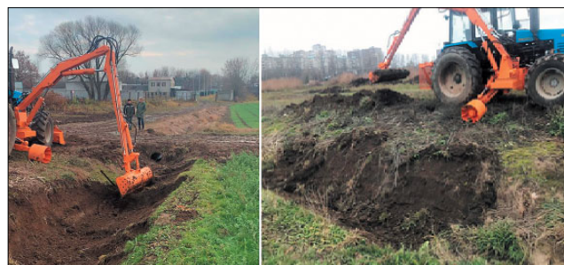
Рис. 1. Каналоочиститель ОКН-0,5 в процессе работы
