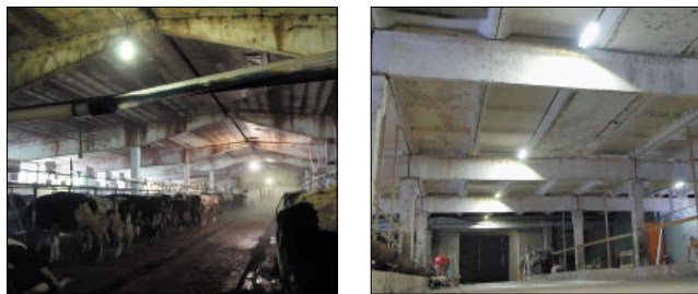
Рис. 3. Сравнение систем освещения коровника на основе ламп ДРЛ-125 общей мощностью 2250 Вт и со светодиодными светильниками общей мощностью 336 Вт
